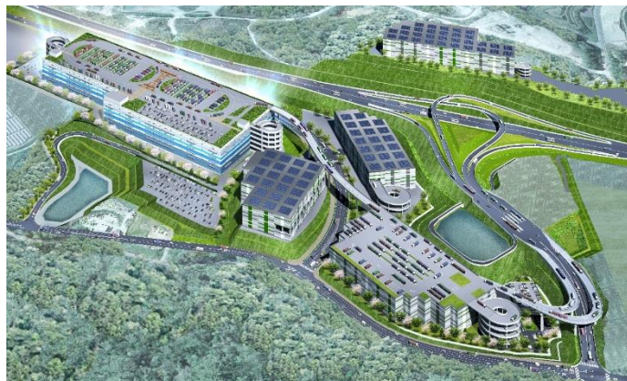
▲三菱地所が京都府城陽市で開発中の次世代基幹物流施設
