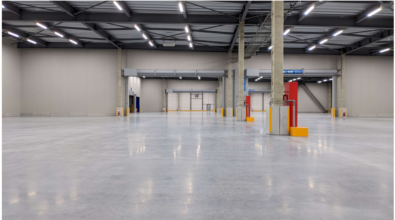
▲「ロジクロス座間小松原」 倉庫コンクリート床写真
