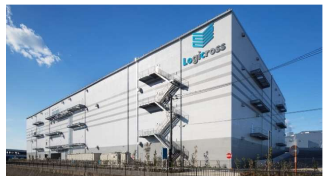
▲「ロジクロス海老名」外観
