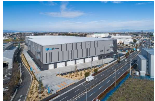
▲「ロジクロス蓮田」竣工写真
