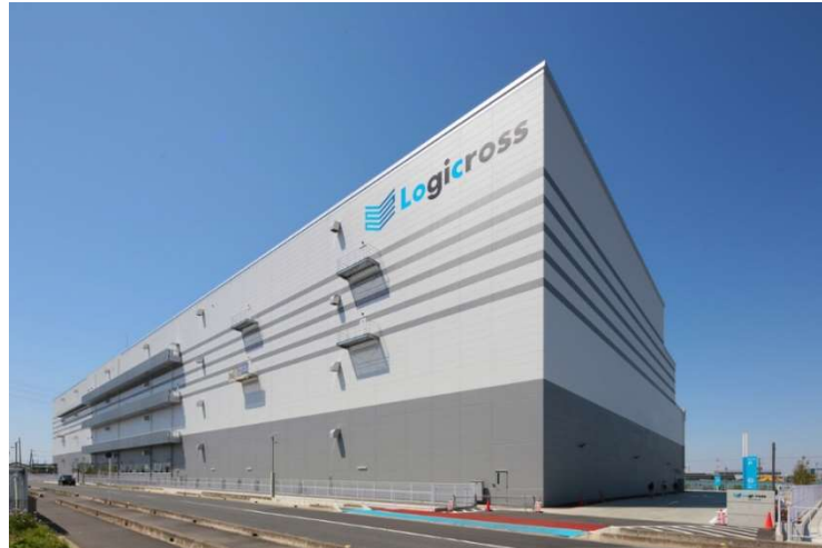
▲ 「ロジクロス春日部」 竣工写真
